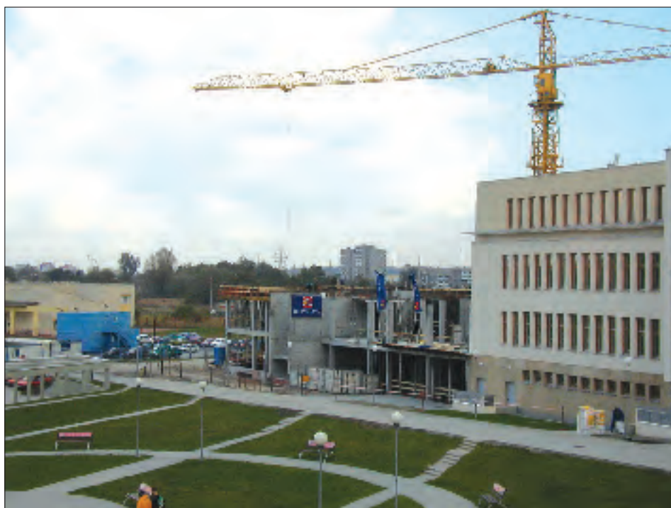
Ryc. 8.14. Budowa Instytutu przebiegała prędko i sprawnie. Fot. M. Baścik.
