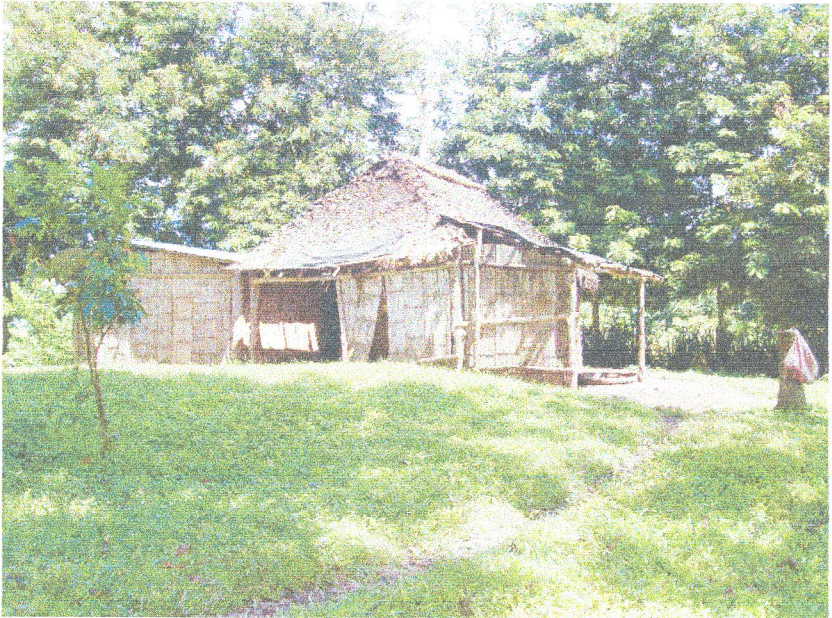
Fotografía 5. Vivienda en mal estado.
