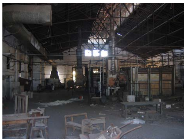
Figura 4.4.17: Interior nave 1, primera planta, fundición y soplado. Fuente: Julián Sobrino Simal (Ref. 31)
