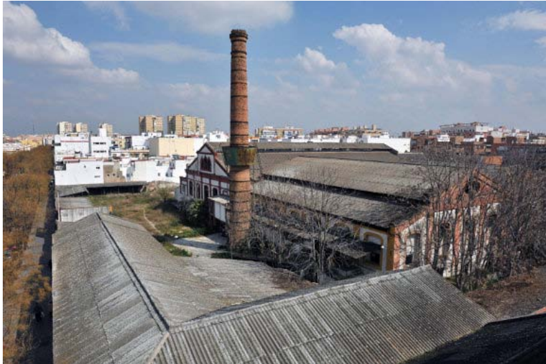
Figura 4.4.4: Vista fachada principal Fuente: Absolut Sevilla. (Ref. 1)
