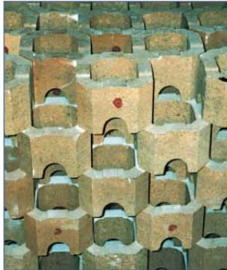
Figura 4.5.12: Típico embalaje de red de refractarios que forman la chimenea.
