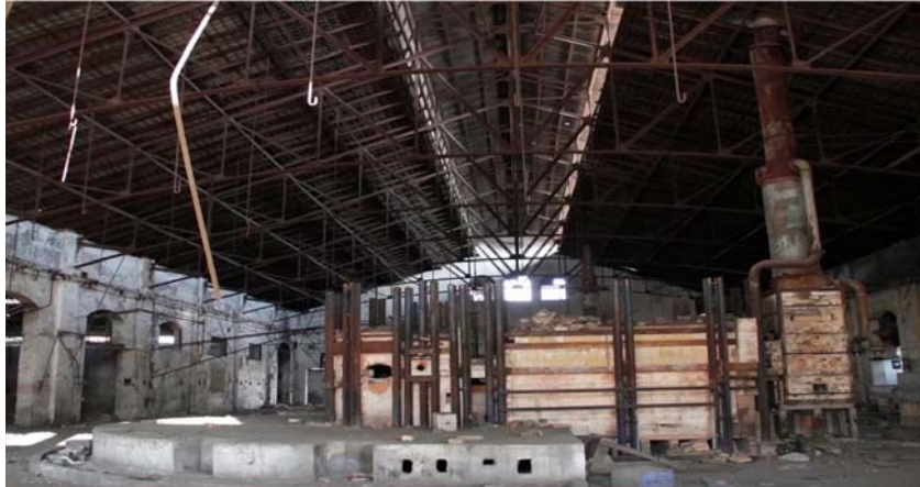
Figura 4.5.19: Horno de recuperación de La Trinidad.
