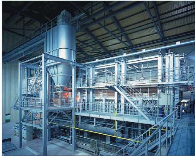
Figura 4.5.17: Imagen horno de regeneración end-fired de 100m 2 .
