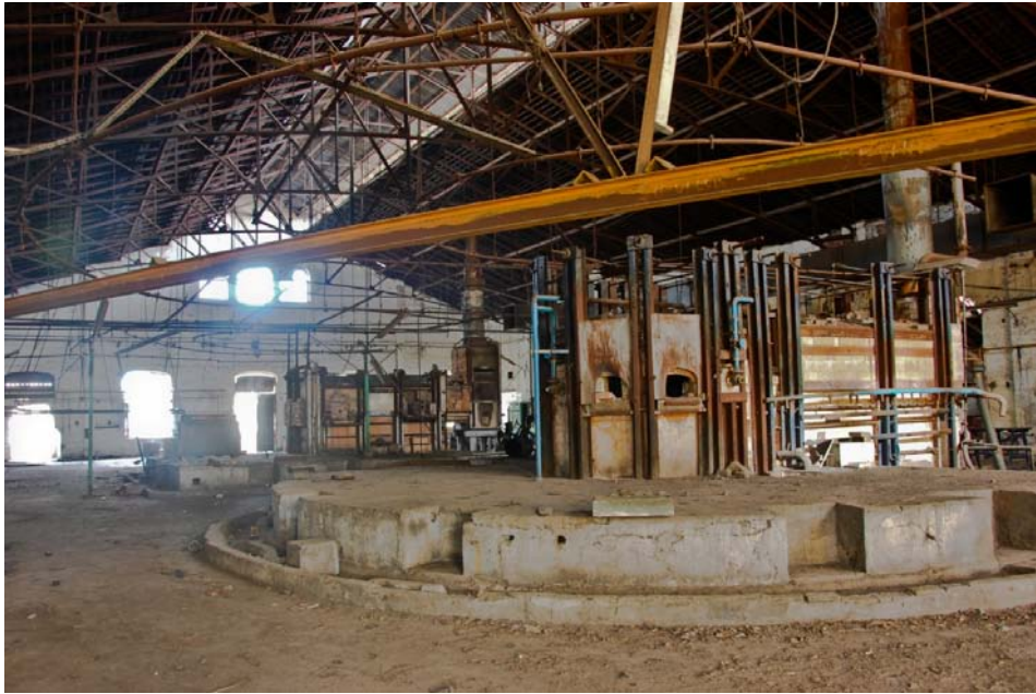
Figura 5.5.17: Fotografía nave hornos interior comparativa 10 Fuente: Julián Sobrino Simal (Ref. 31)
