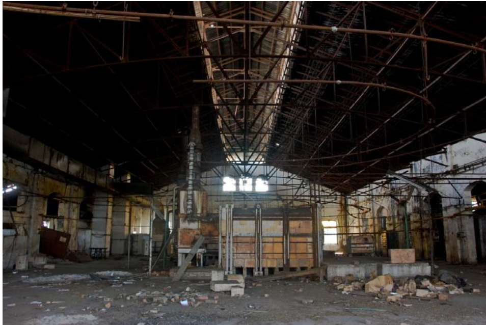
Figura 5.5.11: Fotografía nave hornos interior comparativa 6 Fuente: Julián Sobrino Simal (Ref. 31)
