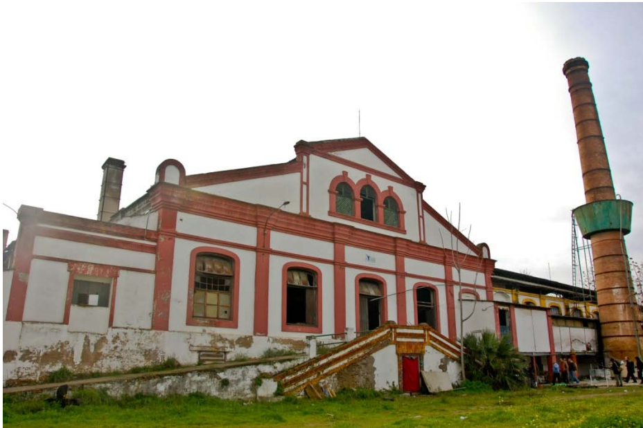
Figura 4.4.13: Fachada principal (frente oeste) Fuente: Julián Sobrino Simal [42](Ref. 31)
