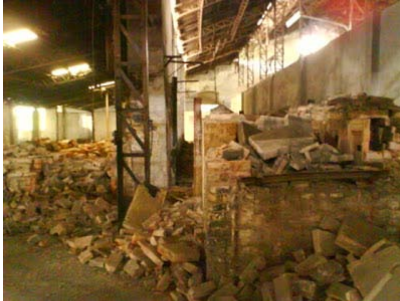
Figura 5.4.27: Horno de recocido demolido. Fuente: Patina Industrial (Ref. 39)
