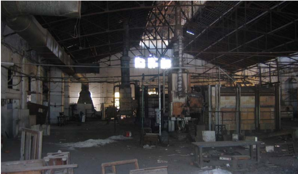
Figura 5.5.13: Fotografía nave hornos interior comparativa 7 Fuente: Julián Sobrino Simal (Ref. 31)
