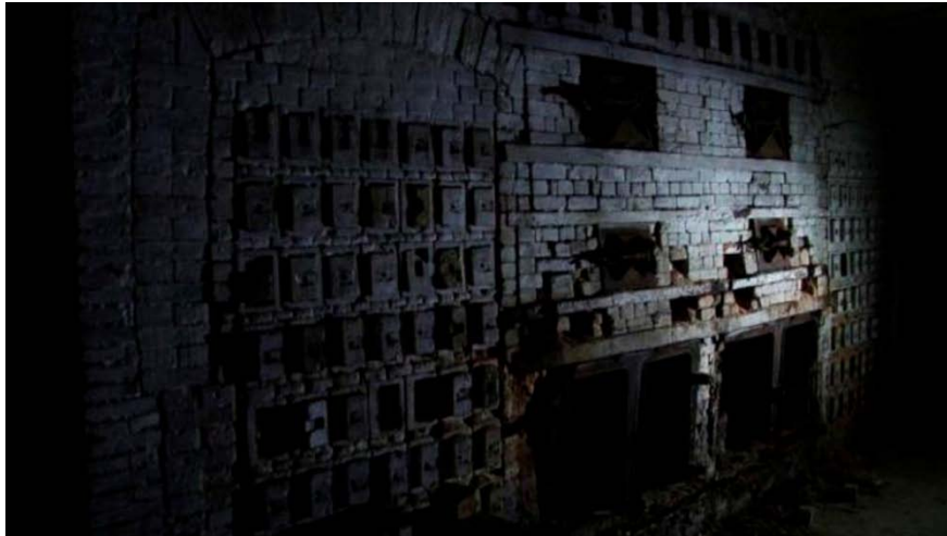
Figura 4.5.29: Caldera de carbón para hornos de recocido del nivel superior.
