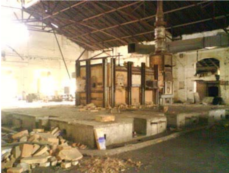
Figura 5.5.19: Fotografía nave hornos interior comparativa 11 Fuente: Cultura de Sevilla (Ref. 26)
