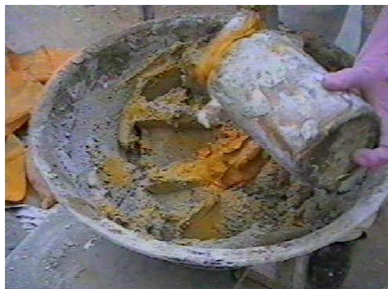
Mezcla del pigmento con el mortero
