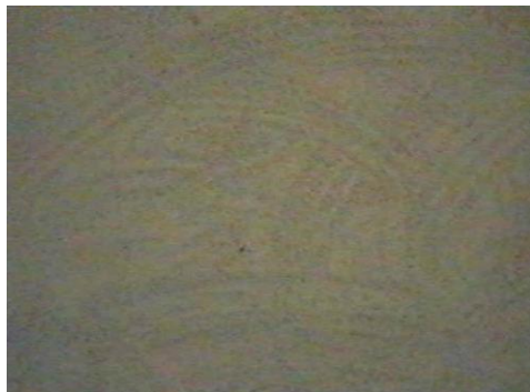
Superficie del mortero tras pasar con el fratás.
