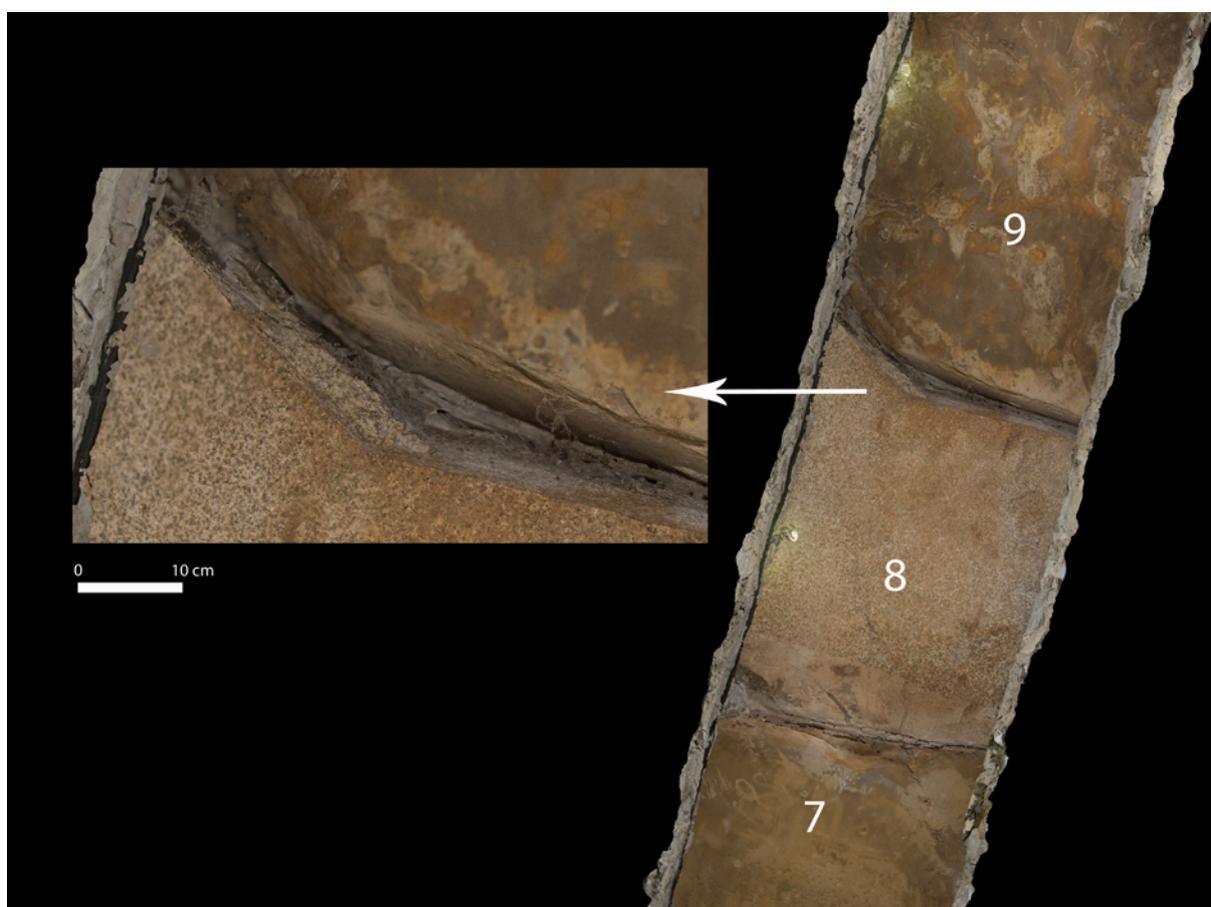
Figura 7. Detalle de corte y desbastado identificado en la losa de granito nº 8 de la cubierta.
