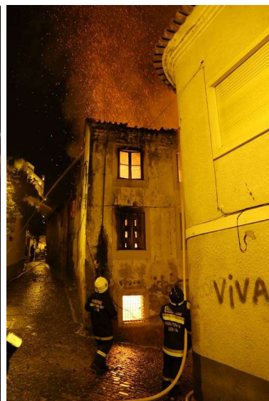
Figura 9 - Foto do Edifício em chamas que ficou totalmente destruído [Jornal de Notícias, Maio de 2016]
