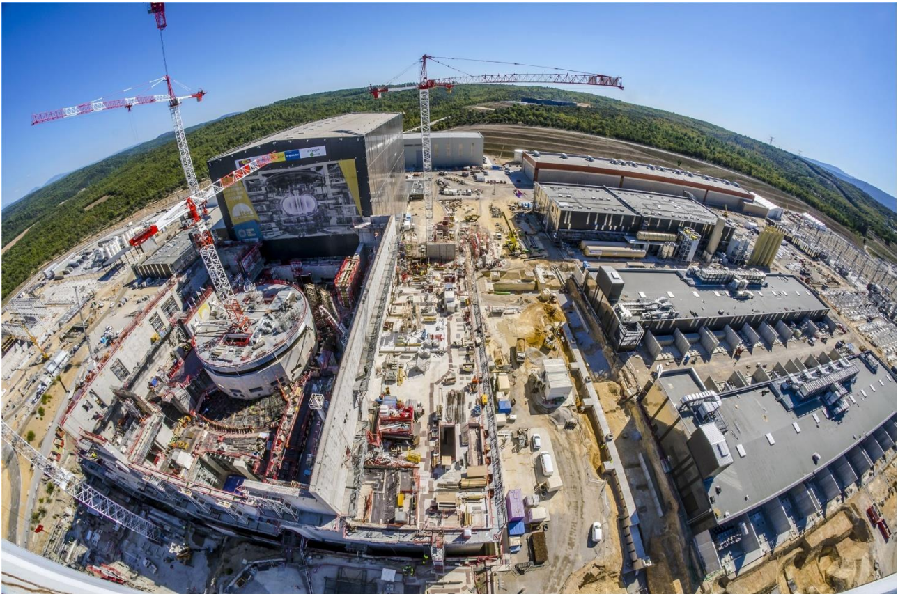
1. ábra Nagy látószögű felvétel a jelenleg épülő ITER berendezés telephelyéről. Bal oldalt elől látható a berendezésnek a későbbiekben otthont adó épület építése. A fotó 2018. október 8-án készült. Forrás: iter.org.
