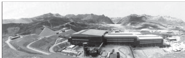
Мідно-цинкова збагачувальна фабрика на копальні Antamina в Перу.
