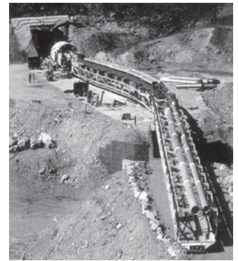
Прохідницький комплекс для будівництва тунелів, шт. Монтана, США.
