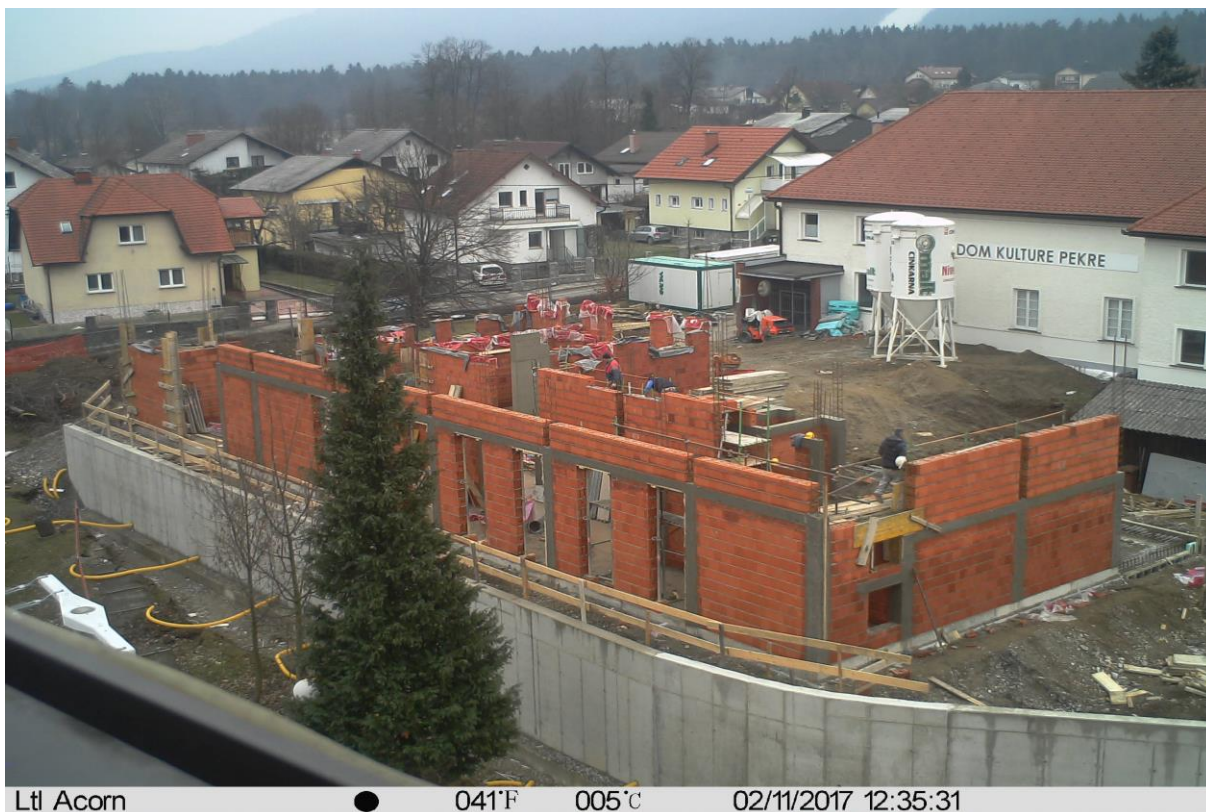
Slika 4.4: Aktivnosti Notranje stene v pritličju – med izvajanjem (datum razviden iz fotografije).
