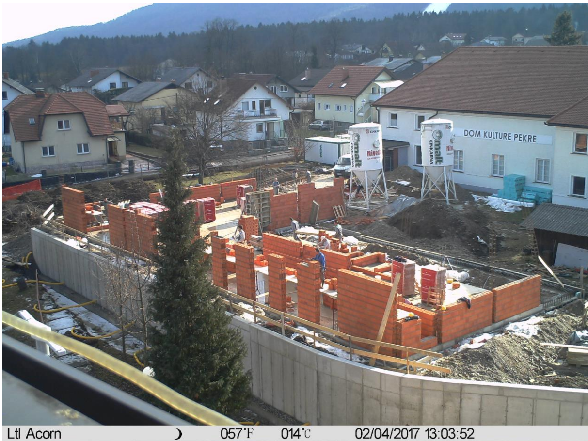
Slika 3.30: Fotografija iz gradbišča za izvedbo elementa Notranje stene v pritličju stavbe vrtca Pekre.
