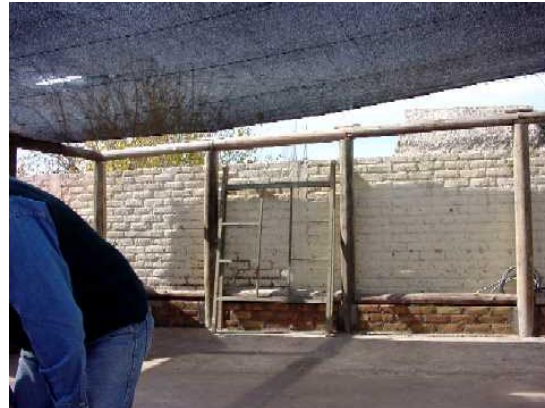
Figura 7: estructura de la quincha.
