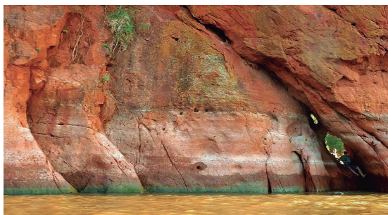
Figura 7. Las cavernas marinas son la evidencia más clara de socavamiento. Se excavan a lo largo de zonas de debilidad de todo tipo, y en especial allí donde las rocas están muy divididas por diaclasas (Holmes, 1978). En la imagen se observa la pequeña caverna desarrollada a partir del socavamiento en zona de fractura en el acantilado de Itá Pytã Punta (imagen por gentileza de Ron Halliday).
