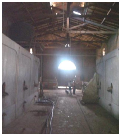
FOTO 6: Bodega Guinle. Se aprovecha el desnivel entre el local de fermentación y la sección de conservación.
