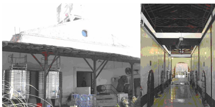
FOTO 8: Bodega en Luján de Cuyo Mendoza, ejemplo de bodega usina con la sección de recepción, molienda y prensado, separada del local de fermentación y la sección de conservación.
