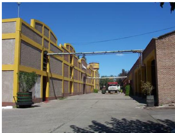
FOTO 4: Sección de recepción, molienda y prensado separada de la sección de fermentación en cuerpos separados de Bodega Baudrón.
