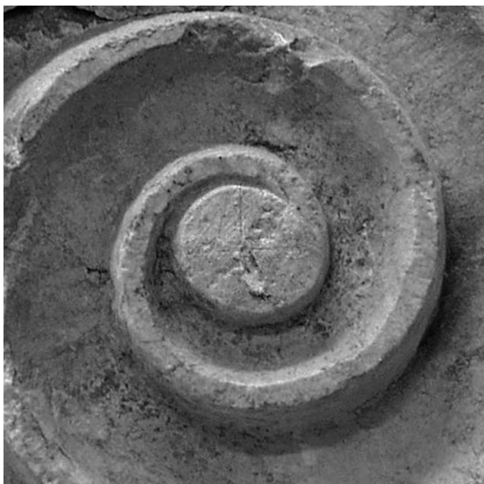
Fig. 7. Gortina, capitello ionico inv. n. 86 GO 3368. Particolare dell'occhio di una delle volute con le tracce del compasso e delle linee ortogonali per il tracciamento della voluta (foto dell'A.).
