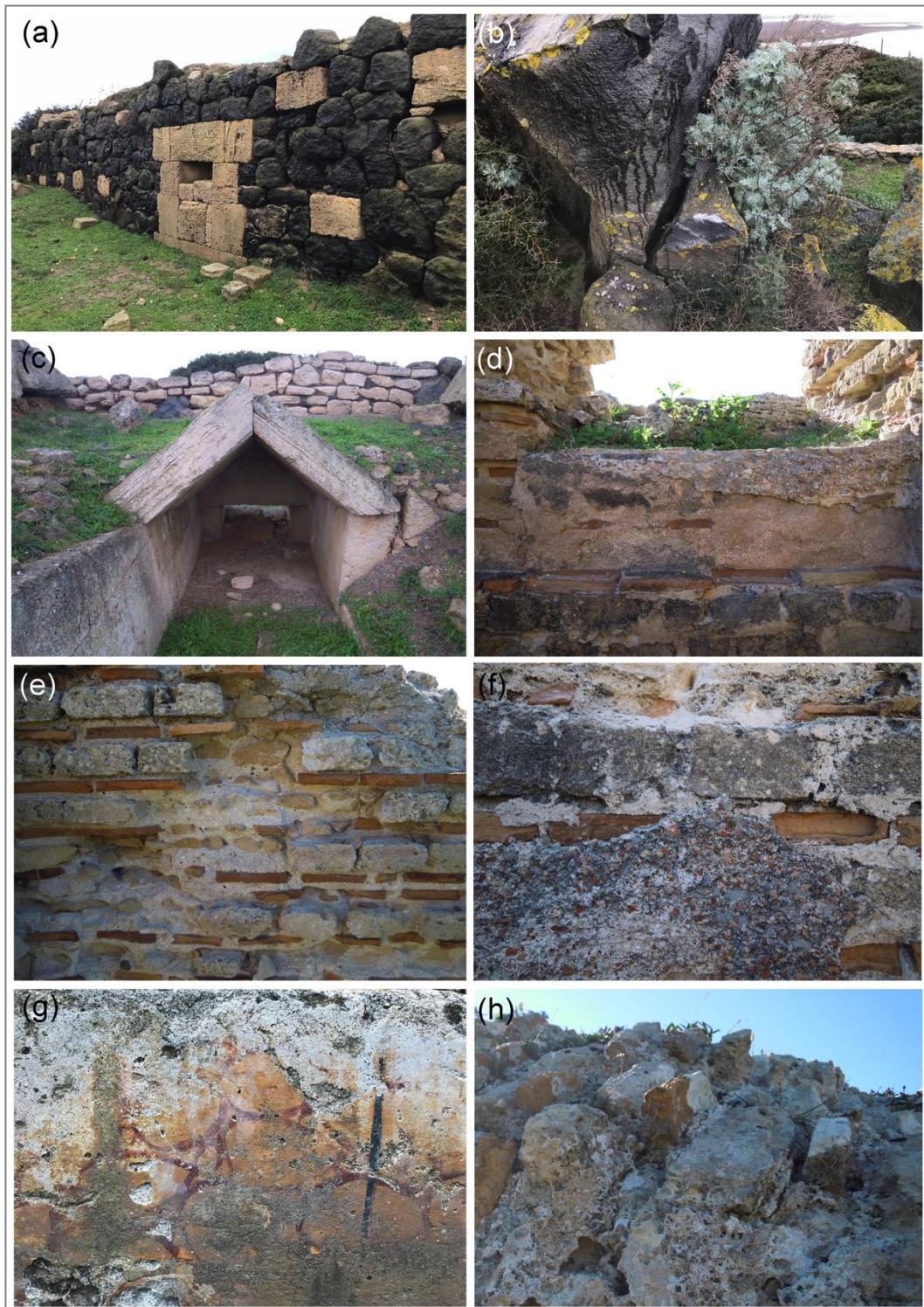
Figura 5.4.2: Campionamento nell'area archeologica di Tharros: (a) parete con conci di arenaria e vulcanite, (b) affioramento di vulcanite nella città alta, (c) copertura spiovente in arenaria, (d) calcestruzzo pavimentale, (e) malta di allettamento dei laterizi, (f) Trullissatio , (g) intonachino affrescato, (h) calcestruzzo delle volte. Foto di Fabio Sitzia.
