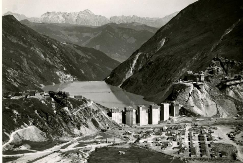
Abbildung 3: Baustelle Kaprun Limberg Sperre um 1950 / Salzburger Landesarchiv 3
