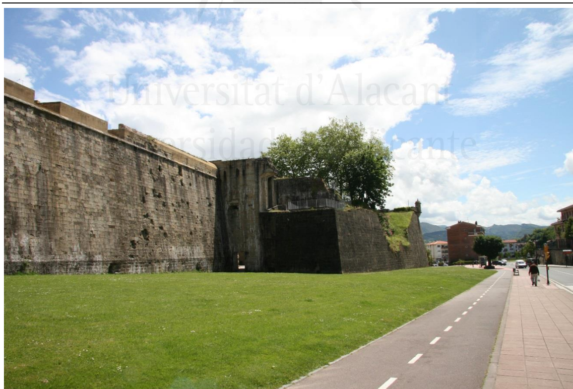
Figura 0.15. Fotografía del baluarte de la Reyna tomada desde el antiguo foso, actual carril bici, bajo la cortina de San Nicolás. Fuente: Fotografía propia tomada en la visita realizada el 29 de mayo de 2014 para un primer reconocimiento in situ de las fortificaciones de Fuenterrabía.
