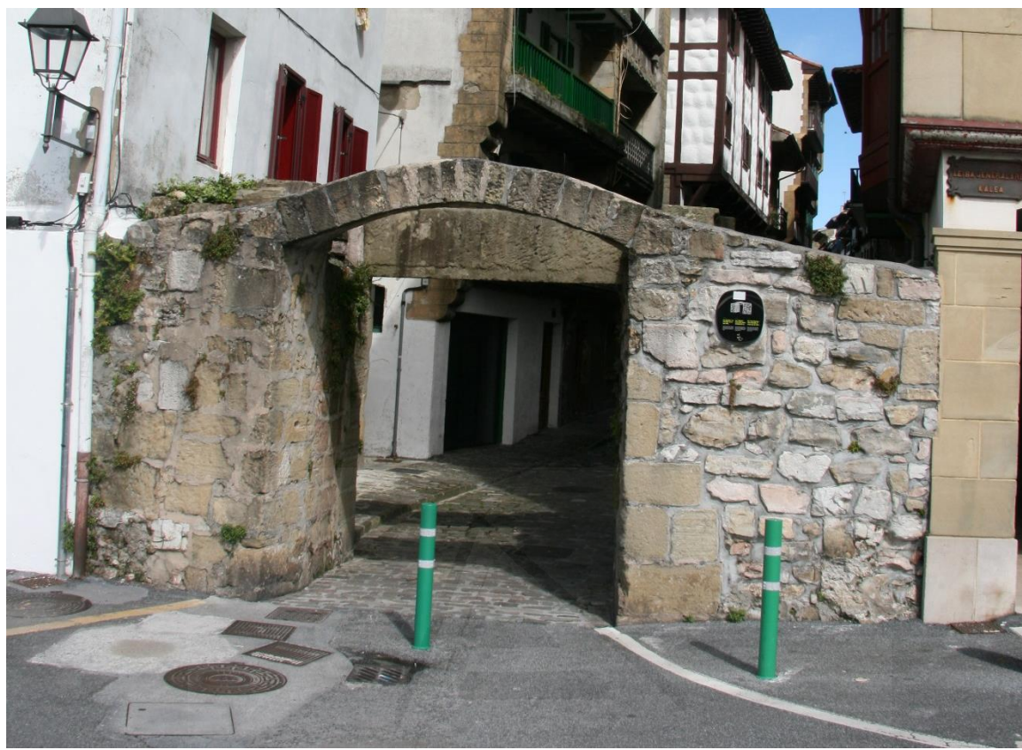
Figura 2.3. Lienzo de origen medieval flanqueando la puerta de San Nicolás, conservado como actual puerta de acceso a la calle Satarka. Fuente: Fotografía propia tomada el 29 de mayo de 2014.
