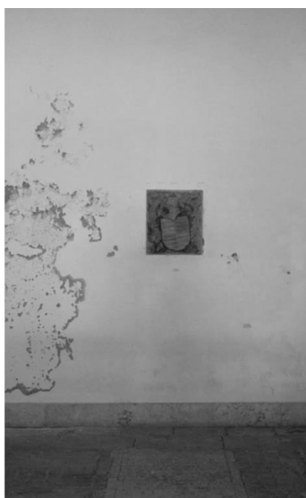
Figura 14 - Cantaria no interior da igreja, 2019.
