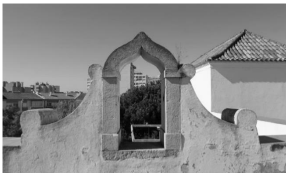
Figura 4 - Janela com moldura em cantaria, 2019.
