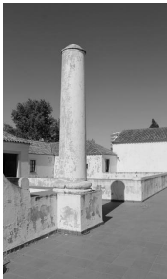
Figura 9 - Área exterior no segundo piso, com vista para a chaminé da cozinha, 2019
