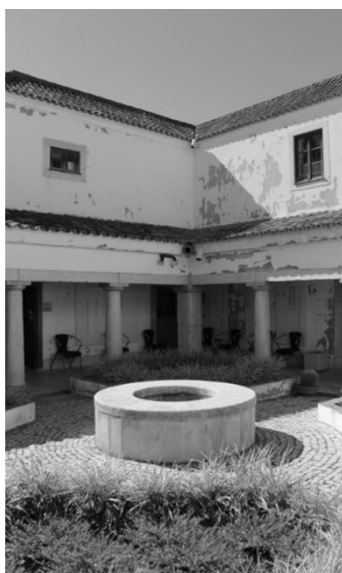
Figura 12 - Claustro quadrangular com acessos a diversas áreas. 2019
