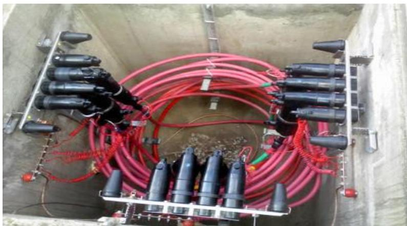
**Figura 52.** Pozo distribuidor media tensión
