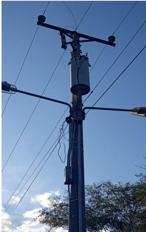
**Figura 62.** Transformador de parqueo
