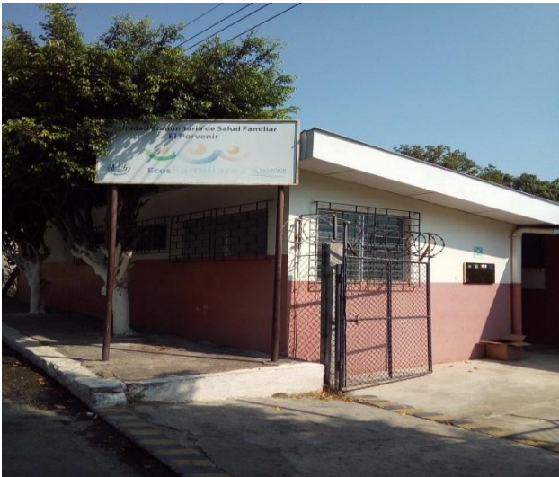
Imagen 8. Unidad Comunitaria de Salud Familiar El Porvenir. Fuente: Propia.
