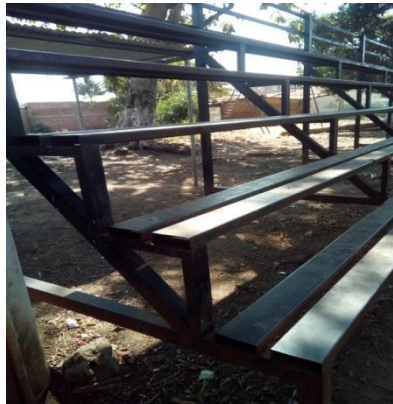
Imagen 36. Graderíos actuales. Fuente: Propia.
