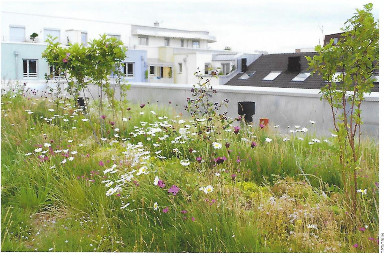
Extensivbegrünung mit Gehölzen durch partielle Substratanhügelungen gelten als ökologisch sehr wertvolle Dachbegrünungsformen.
