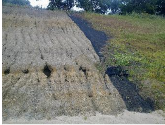
Figura 382. Efecto de la vegetación protegiendo taludes contra la erosión.
