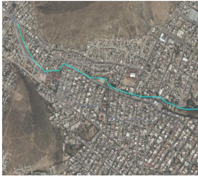
Figura 208. Vista aérea de la calle Novena, en donde el arroyo (línea celeste) recorre su cauce de manera subterránea a través del entubamiento señalado en la Figura 207.
