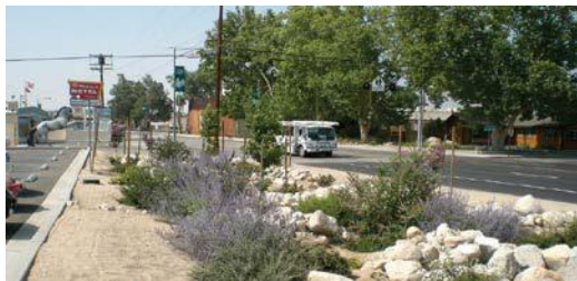
Figura 389. Ejemplo de construcción de área de absorción en un camellón, Los Ángeles, CA.
