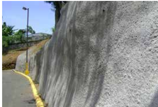
Figura 380. Ejemplo de concreto lanzado en taludes.
