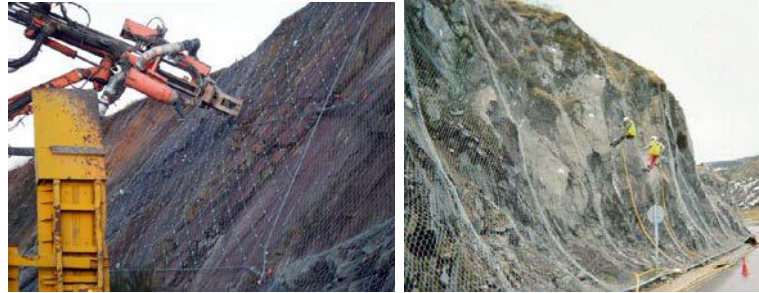
Figura 379. Instalación de mallas para protección de taludes.
