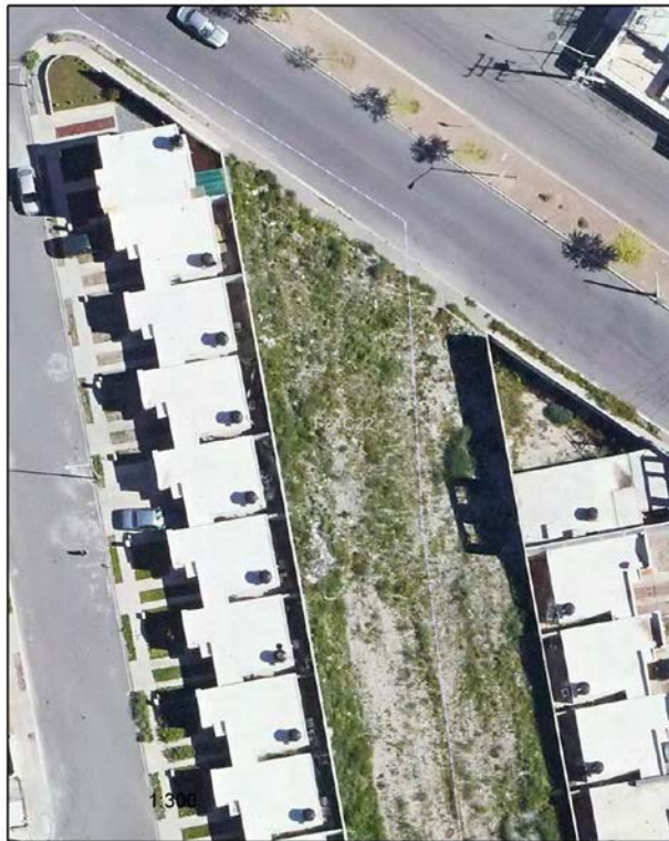
Figura 197. Acercamiento a una de las zonas de conflicto dentro de la Col. Santa Elena. Se muestra cómo termina el arroyo y comienza la calle.
