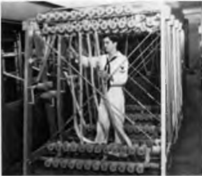
Mark-I управлялось программой, которая хранилась на бумажной перфоленте
