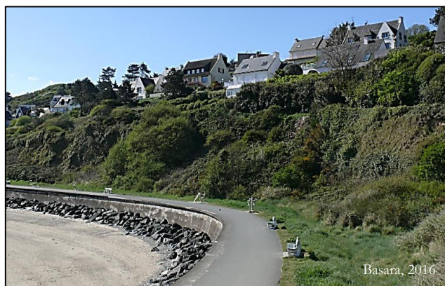
Digue-promenade et drainage du versant (Plérin, 22)
