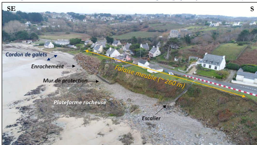
Fig. 65 : Vue aérienne de l'anse du Moulin de la Rive (photographie : J. Ammann, 2018).
