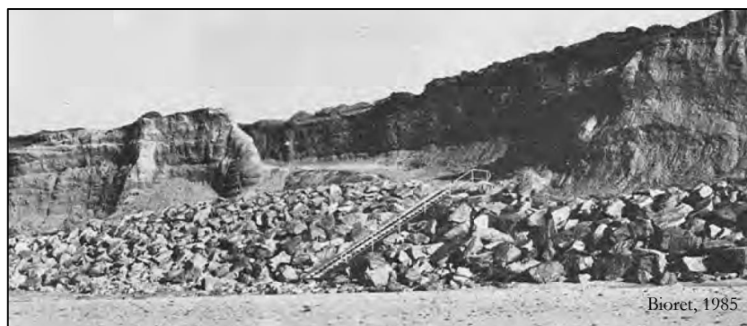
Fig. 15 : Enrochement mis en place au pied des falaises meubles de la Mine d'Or à Pénestin, dans les années 1970.
