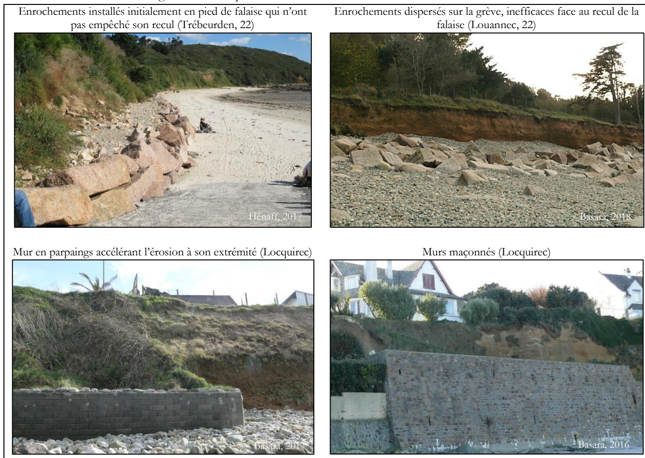
Fig. 40 : Techniques de durcification de la base des falaises meubles.
