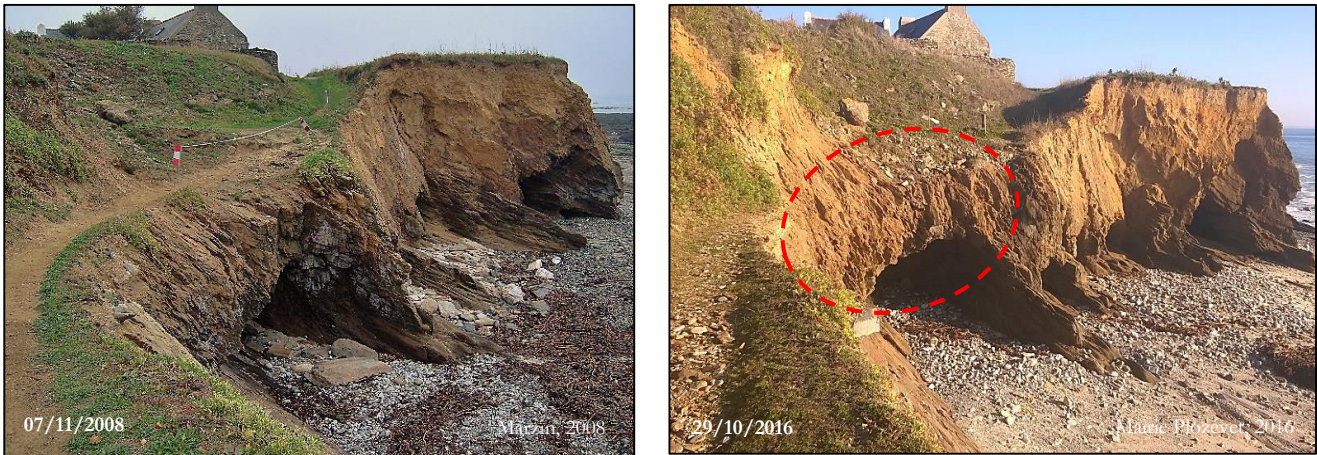
Fig. 135 : Effondrement de falaise recoupant le sentier côtier à Poulbréhen suite aux tempêtes de février 2014. Vue depuis le nord-ouest.
