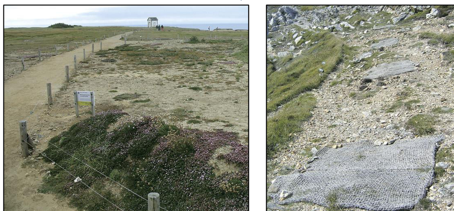
Photo de gauche : réhabilitation de litière et de biomasse sur la falaise de Pen-Hir (Presqu'île de Crozon). Photo de droite : Pose de géotextile pour favoriser le couvert végétal sur la falaise de Port-Coton (Belle-Ile).
