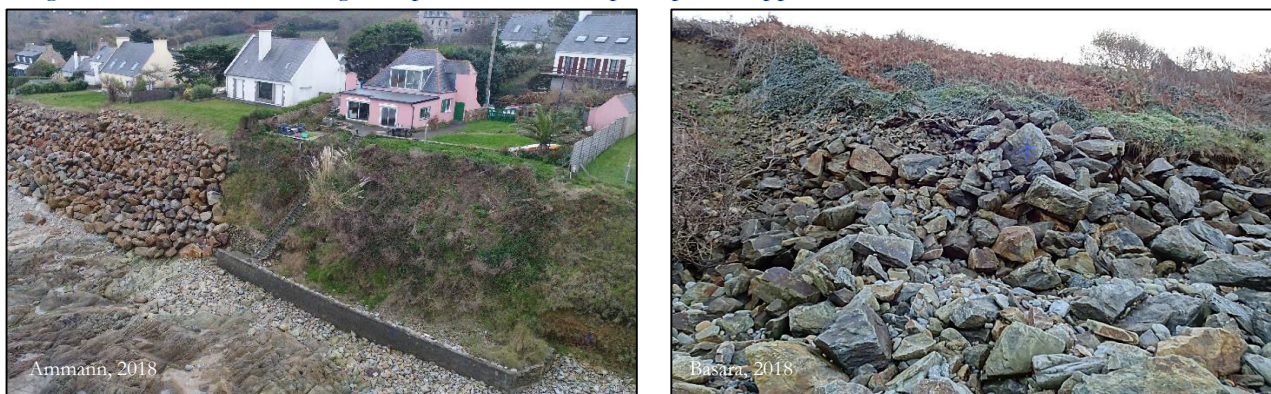
Enrochement et mur de protection dans le secteur 3 (vue prise depuis le NW)
