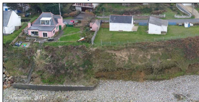
Fig. 243 : Érosion exacerbée à l'extrémité du mur de protection ("effet de bout") au Moulin de la Rive, à Locquirec.
