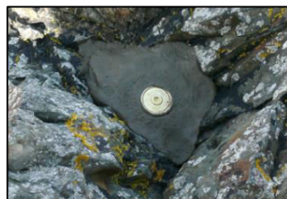
Clou topographique fixé sur le platier à Pléneuf-Val-André.
