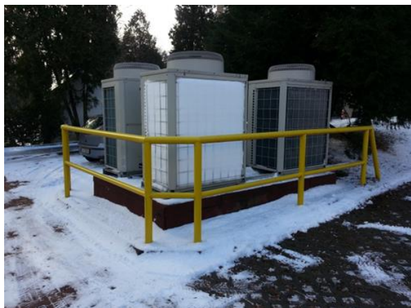
Rys. 3. Ilustracja zjawiska szronienia parownika
