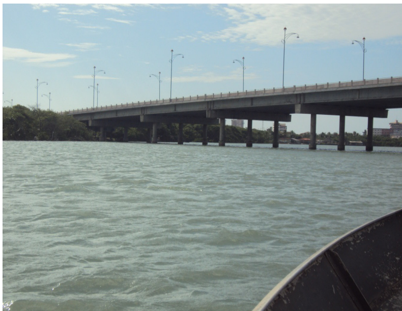
Figura 12 - Ponte da Sabiaguaba (julho de 2011).
