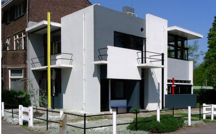
Fig. 09: Casa Schroder, Utrecht Holanda, 1924, Ritveld. Vista exterior.
