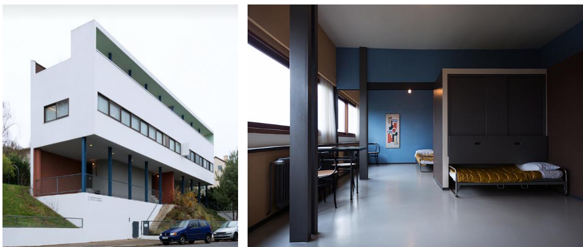
Fig. 12: Weissenhof-Siedlung Houses , 1927, Le Corbusier e Pierre Jeanneret. O facto de toda a parte estrutural do edifício funcionar de forma independente em relação às restantes partes constituintes, permite a abertura de vãos contínuos, uma maior liberdade na organização interior da habitação e uma maior permeabilidade nos acessos.
