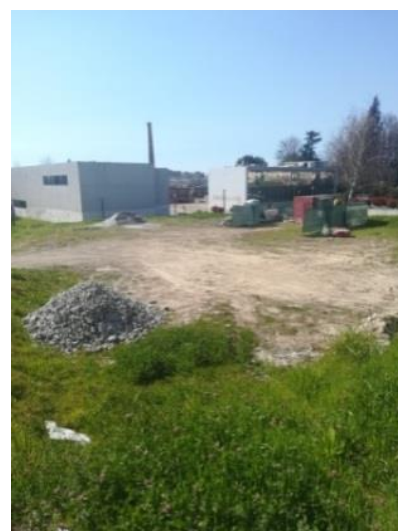
Fig. 98: Foto de local de intervenção 2 sentido Este/Oeste.
