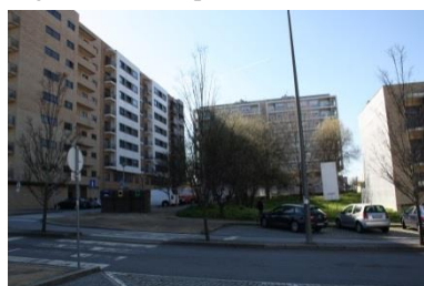
Fig. 87: Vista exterior ao quarteirão.
