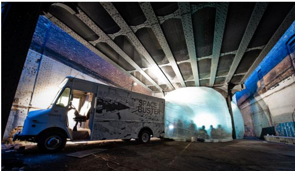
Fig. 59: Spacebuster , Atelier Raumlaborbelim. Uma unidade insuflável com grande capacidade de ser implantada em locais com características morfológicas distintas que pode ser montada/desmontada com facilidade e rapidez. O seu transporte e armazenamento é feito através de uma carrinha o que lhe confere um carácter móvel.
