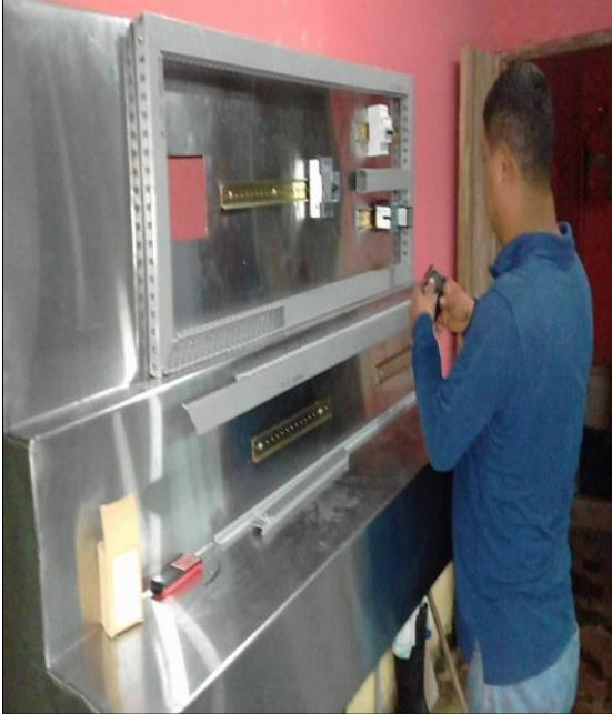
Instalación de los Relé
