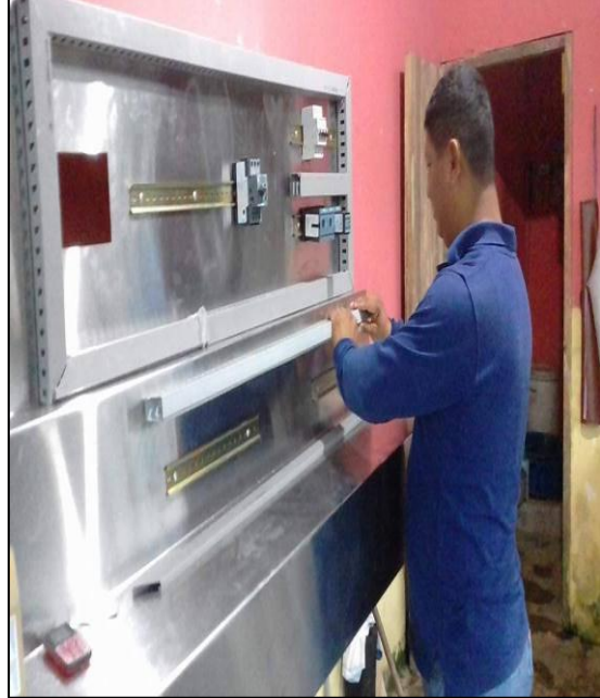
Térmicos Instalación de canaletas
