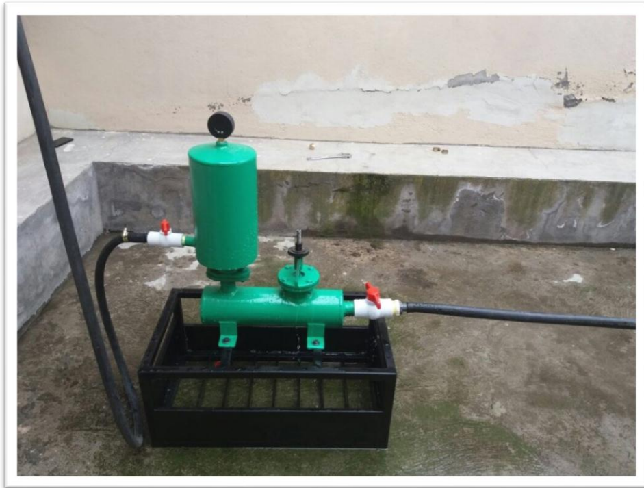
Figura 13: Colocación de llaves de paso y mangueras
