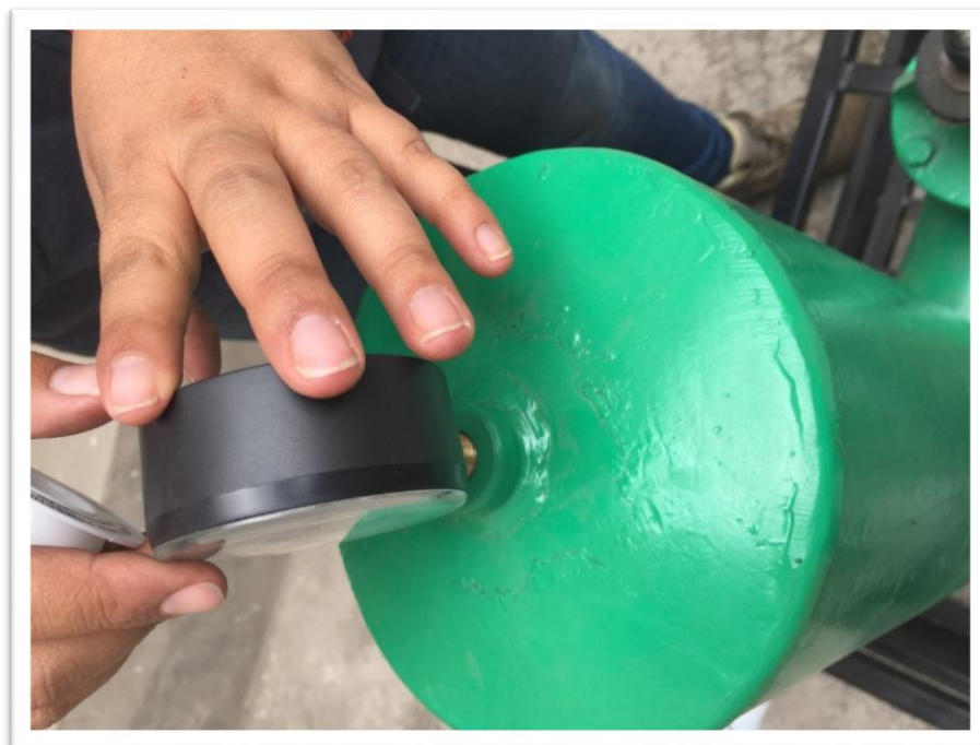
Figura 12: Colocación de manómetro
