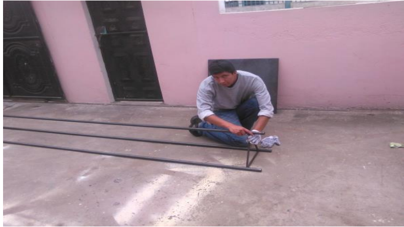
Colocación de tubos y barrillas de la torre
