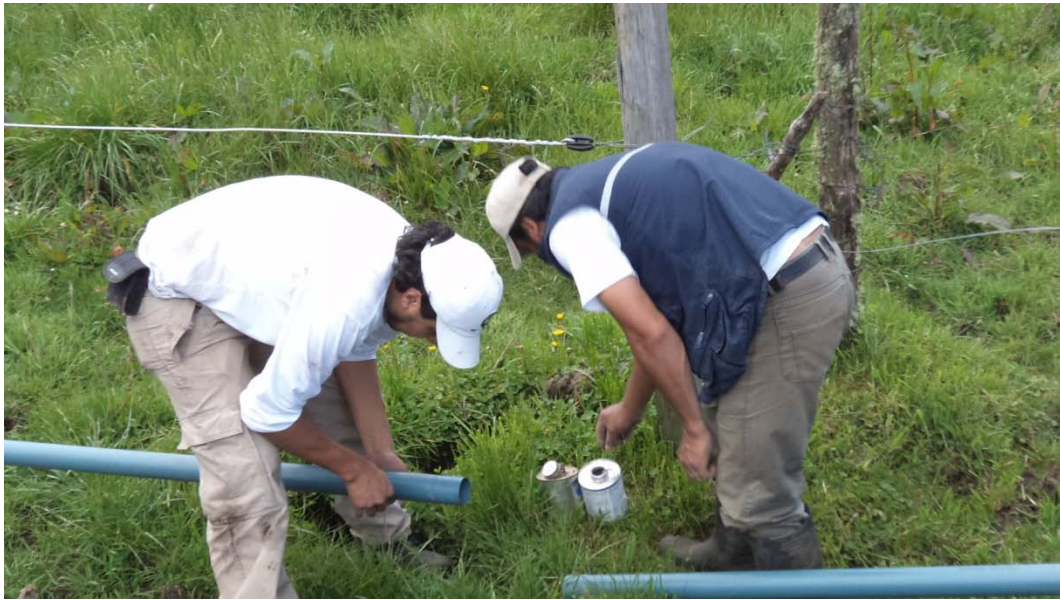
Unión de tubería para la instalación de la misma.
