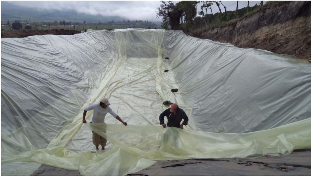
Recubrimiento con plástico el reservorio construido.
