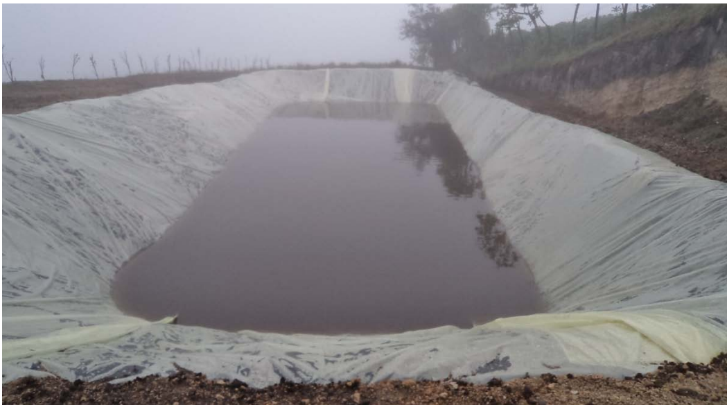
Reservorio Lleno a la mitad.
