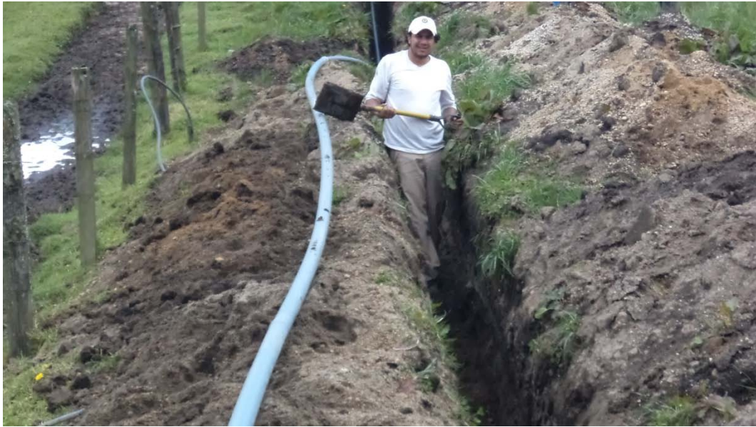
Colocación de tubería en la zanja
