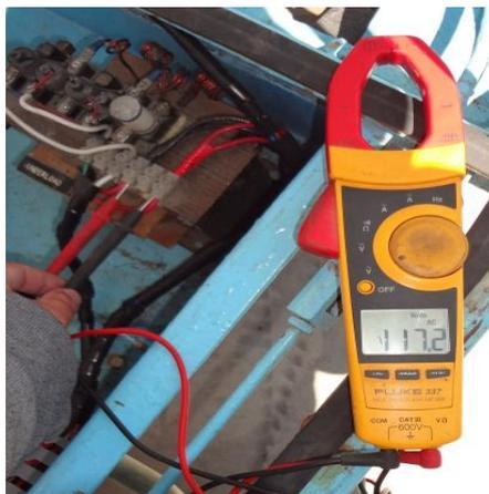
**Figura 3. 14** Medición de Voltaje Entregado por la Red de la Empresa Distribuidora para el Bobinado Primario del Transformador.
