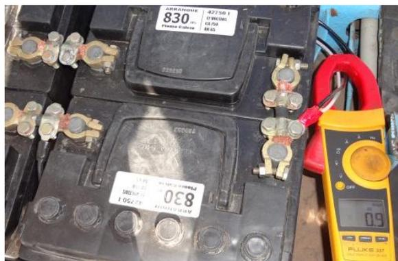
**Figura 3. 20** Medición de Corriente Consumida por el Sistema de Control de 12V del PLC y la Ventilación del Cargador.
