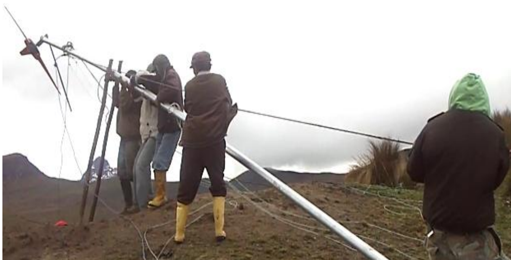
Figura 33 Preparación de la torre para su emplazamiento.
