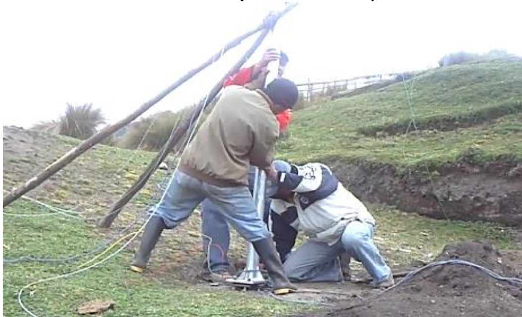
Figura 35 Vista del la torre ajustándose a los anclajes.
