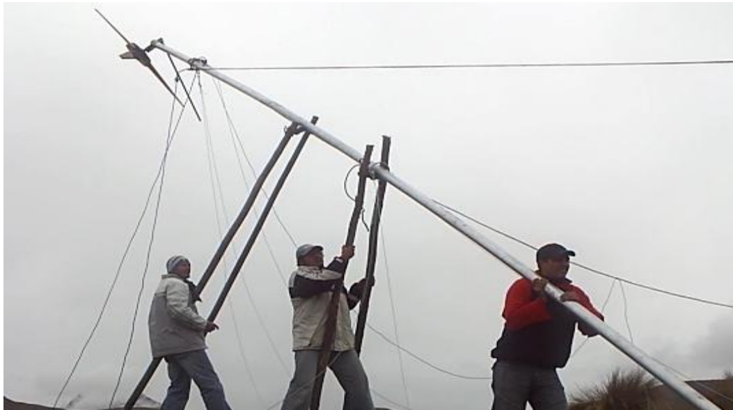
Figura 34 Torre en el momento de la instalación.
