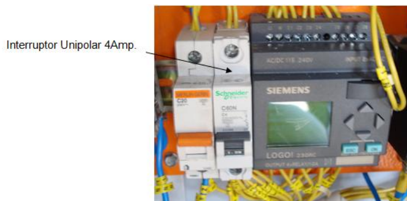
Figura 3.13. Protección del analizador, voltímetro y logo.
