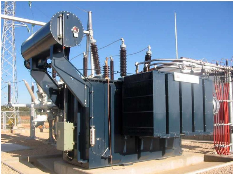
Fig.2 Transformador de Potencia
