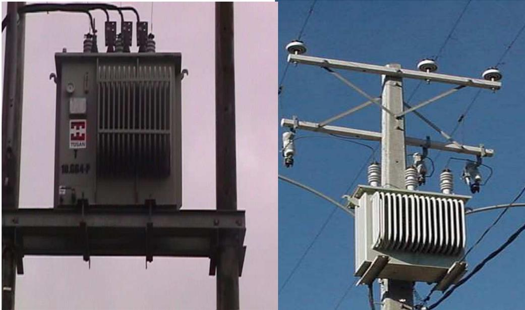
Fig 4 Transformador de distribución tipo plataforma Fig 5 Transformador de distribución tipo poste
