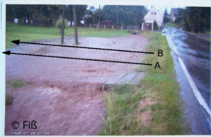
Abbildung 18: Überflutung von Straße und Brücke infolge zu kleiner Durchlässe zum Hochwasser 2009 (Fiß).
