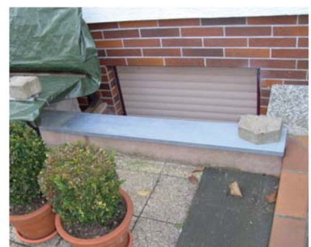
Hochgemauerte Kellerfensterschächte (Quelle [5])
