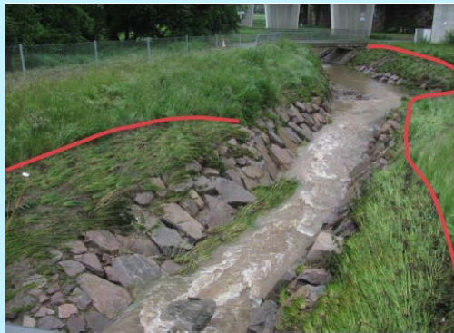
Abbildung 19, links: Geschwemmsellinie markiert durch plattgedrücktes Gras (IÖR, 2018), (rechts) Geschwemmsellinie markiert durch Treibgut (LfULG, 2015)
