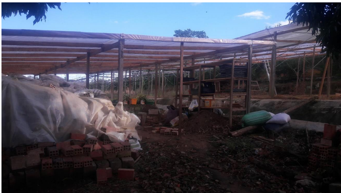
Figura 9: Espacio de control de condiciones ambientales. Elaboración propia.
