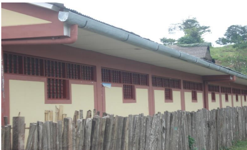
Figura 3. Vista del frontis de la I.E. Primaria N° 0361
