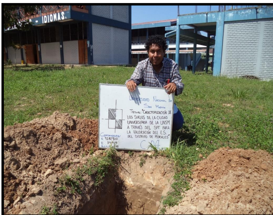
Foto 8: Excavación de la calicata N° 04
