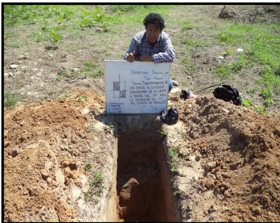
Foto 10: Excavación de la calicata N° 06
