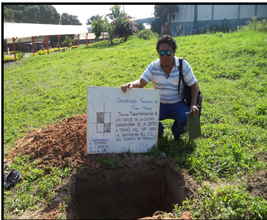
Foto 5: Excavación de la calicata N° 01
