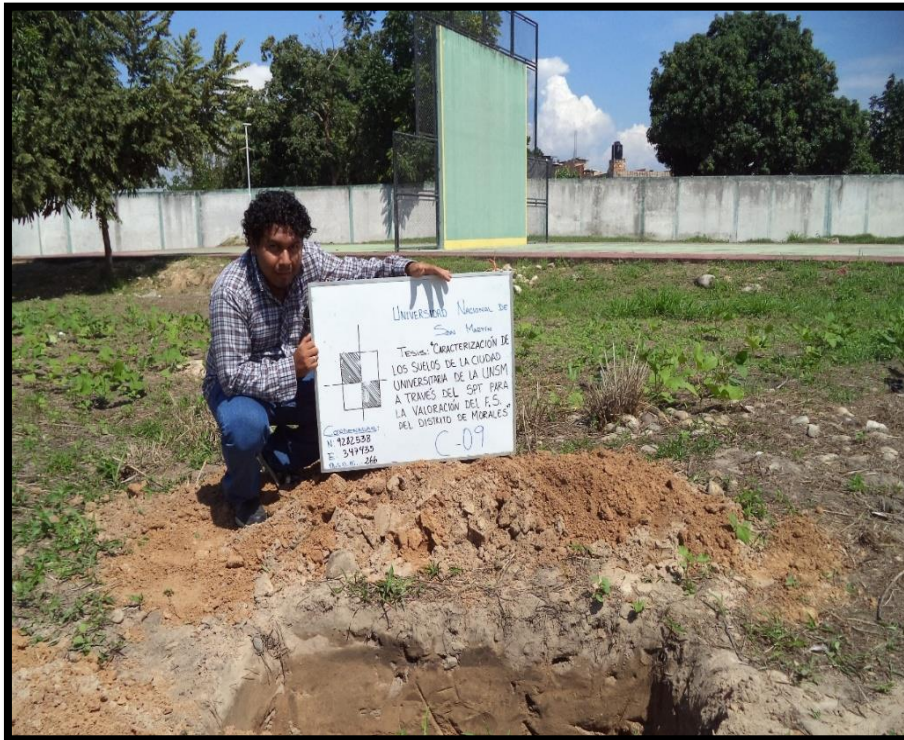
Foto 13: Excavación de la calicata N° 09
