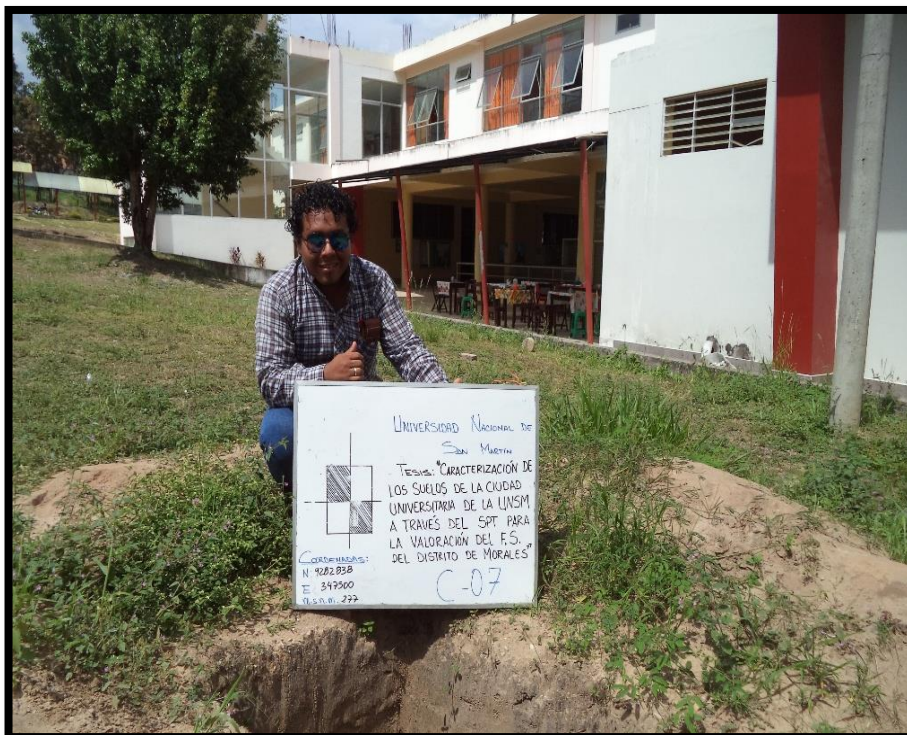
Foto 11: Excavación de la calicata N° 07
