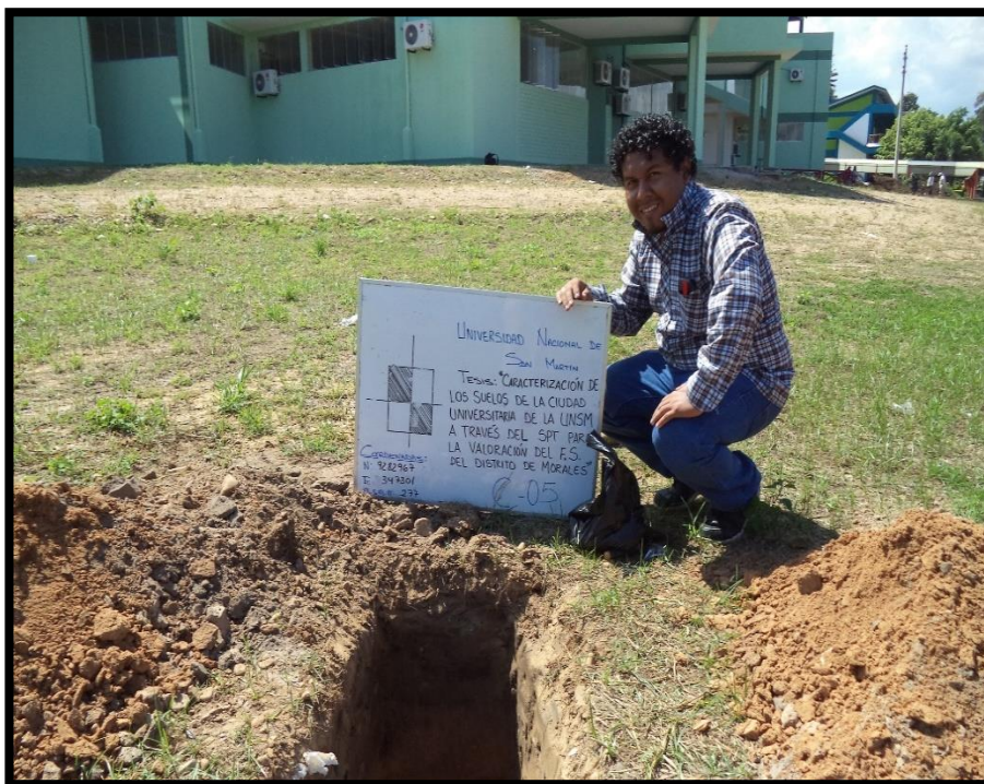
Foto 9: Excavación de la calicata N° 05
