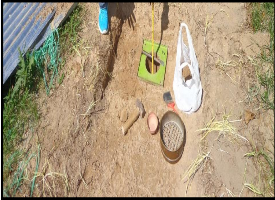
Foto 23: Pruebas de Compactación "In Situ" (Densidad de Campo)
