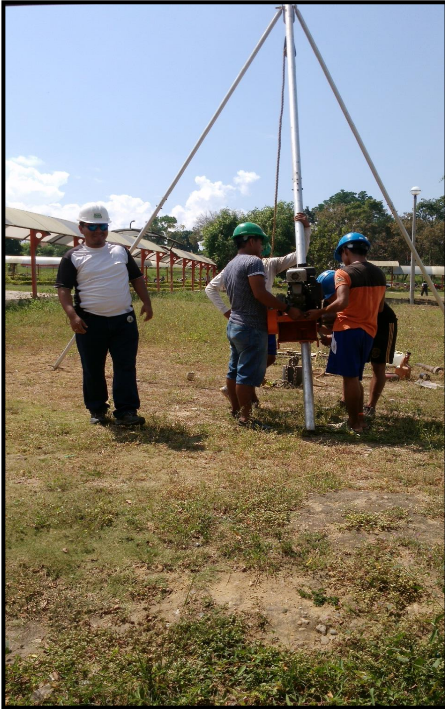
Foto 29: Ensayos del SPT
