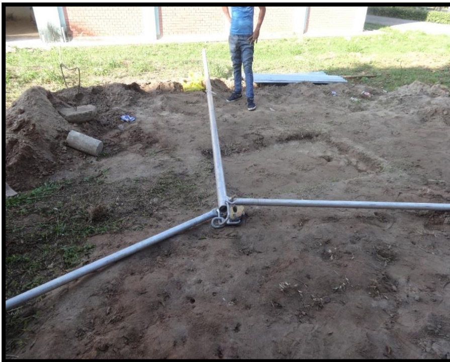
Foto 26: Armado del trípode
