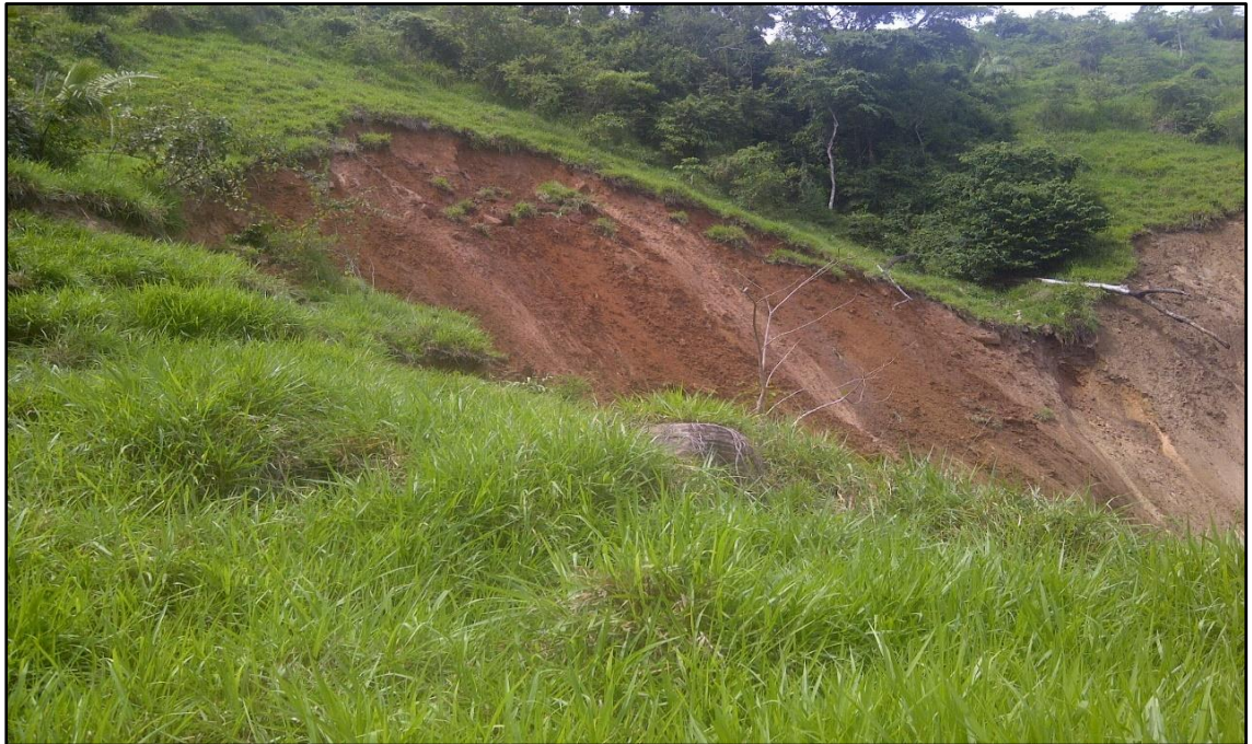
Foto N° 10: En la foto se muestra la presencia de pastizales en el talud superior del deslizamiento rotacional tramo km 08+000 al km 08+300 de la carretera.
