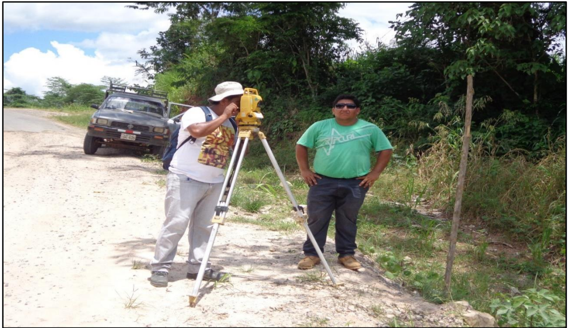
Foto N° 12: En la foto se muestra el trabajo del topógrafo en el levantamiento topografico del tramo en estudio km 08+000 al km 08+300.
