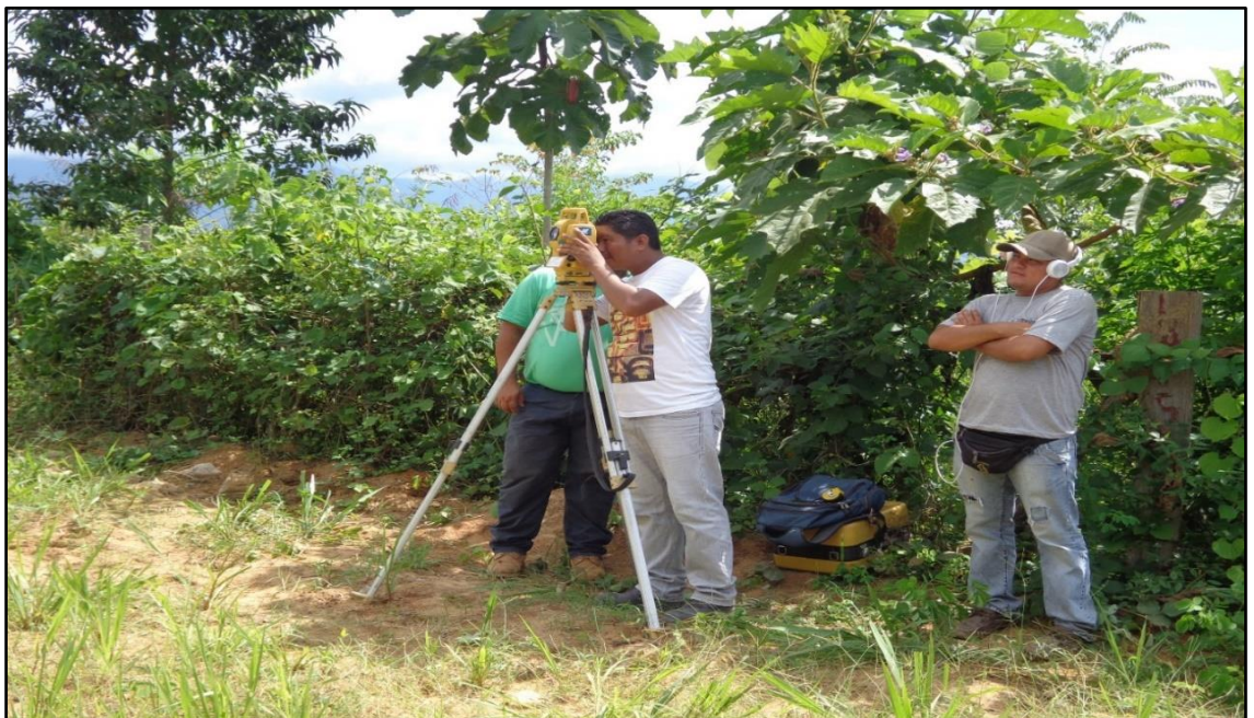
Foto N° 11: En la foto se muestra el trabajo del topógrafo en el levantamiento topográfico del tramo en estudio km 08+000 al km 08+300.
