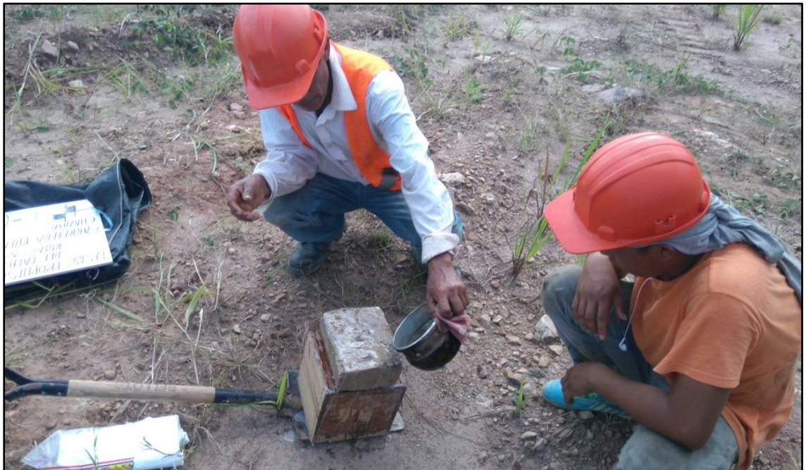
Foto N° 21: En la foto se observa el recubrimiento con cera de la muestra de suelo de la calicata C-1 para conservar sus propiedades físicas y químicas en la progresiva km 08+090.
