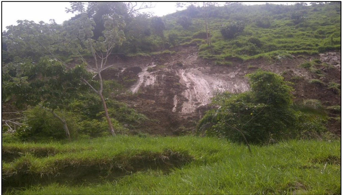
Foto N° 09: En la foto se muestra el desplazamiento de la masa hacia la parte inferior del talud superior en el tramo km 08+000 al km 08+300 de la carretera shapaja – Chazuta.
