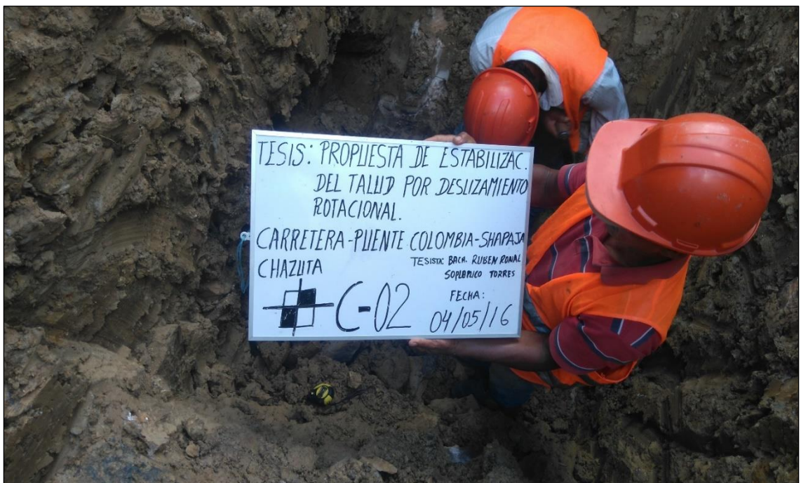
Foto N° 19: En la foto se muestra la calicata C-2 y la extracción de la muestra de suelo con ayuda del personal obrero en la progresiva km 08+200 de la carretera Shapaja – Chazuta.
