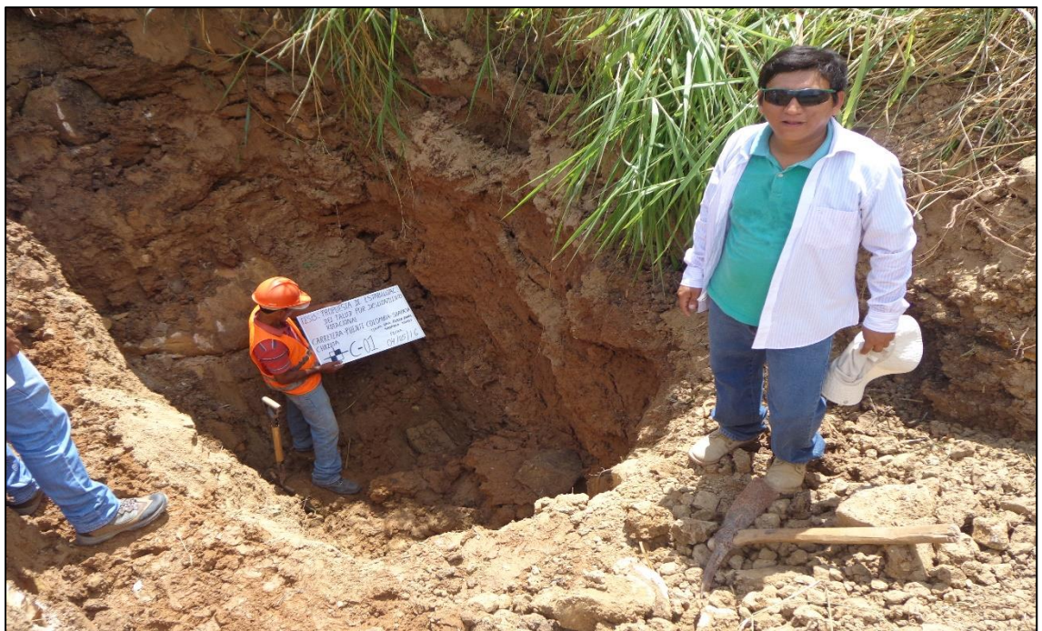
Foto N° 17: En la foto se observa la calicata C-1 y la extracción de la muestra de suelo con ayuda del personal obrero en la progresiva km 08+090 de la carretera Shapaja – Chazuta.
