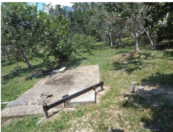
Foto N° 01: Tratamiento existente (tanque séptico y pozo percolador).
