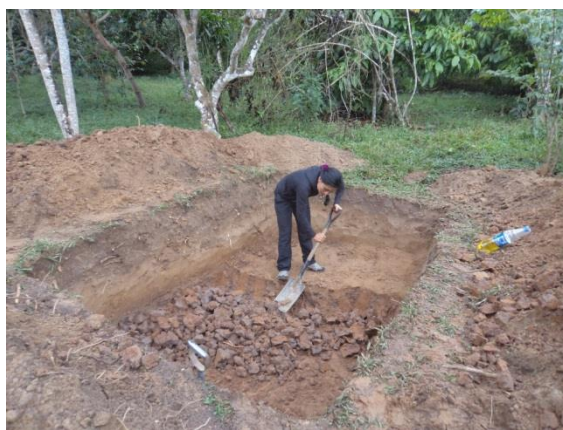
Foto N° 04: Realizando trabajos de excavación de la poza.
