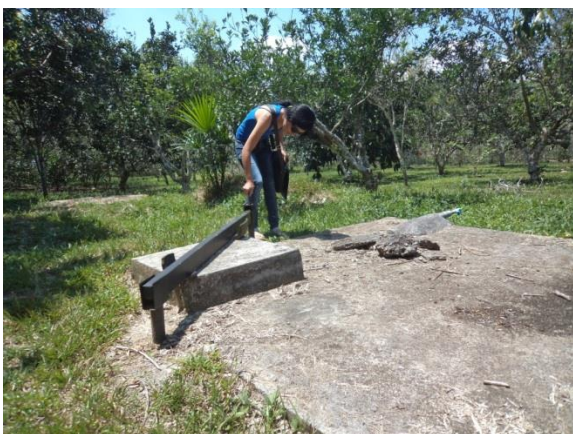
Foto N° 03: Reconocimiento del tratamiento existe y selección del lugar.
