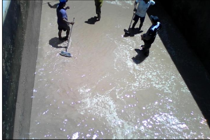
Fotografía N°1: Limpieza de la Planta de Tratamiento de Agua Potable - Moyobamba
