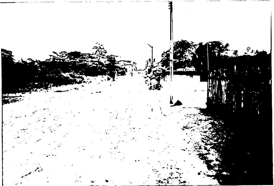
AV. ALFONSO UGARTE (NO EXISTE PENDIENTES APROPIADA QUE PERMITAN LA EVACUACIÓN DE LAS AGUAS SUPERFICIALES EN EL MENOR TIEMPO)
