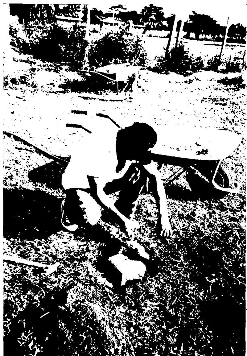
TRABAJOS TOPOGRÁFICOS (FIJACIÓN DE HITOS CON CONCRETO)
