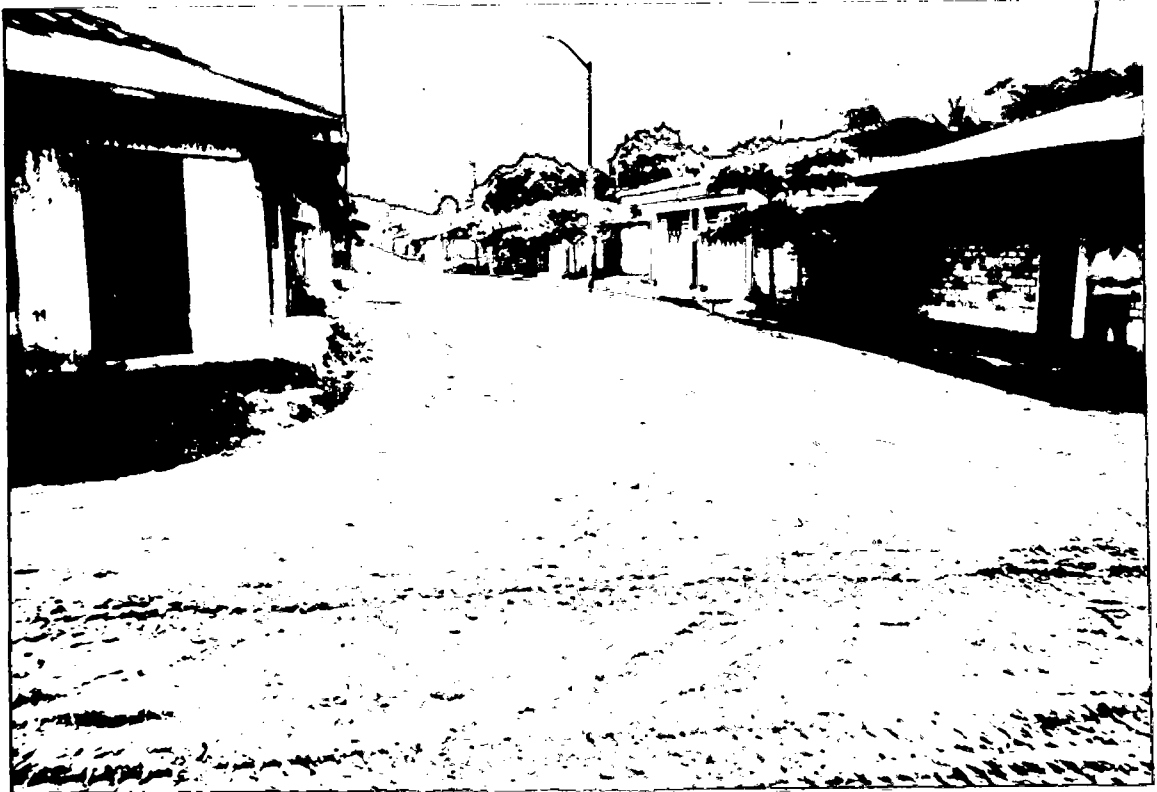
JR. NICANOR REÁTEGUI (DEFICIENCIA DE PENDIENTE TRANSVERSAL Y LONGITUDINAL, PROPICIA LA ACUMULACIÓN DE AGUAS SUPERFICIALES)
