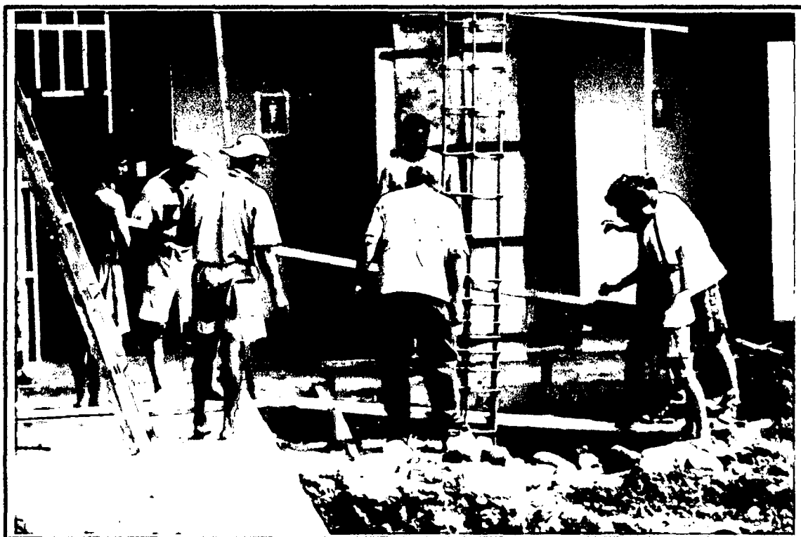
Anexo N° 8.2: Colocación del acero de columnas en las zapatas
