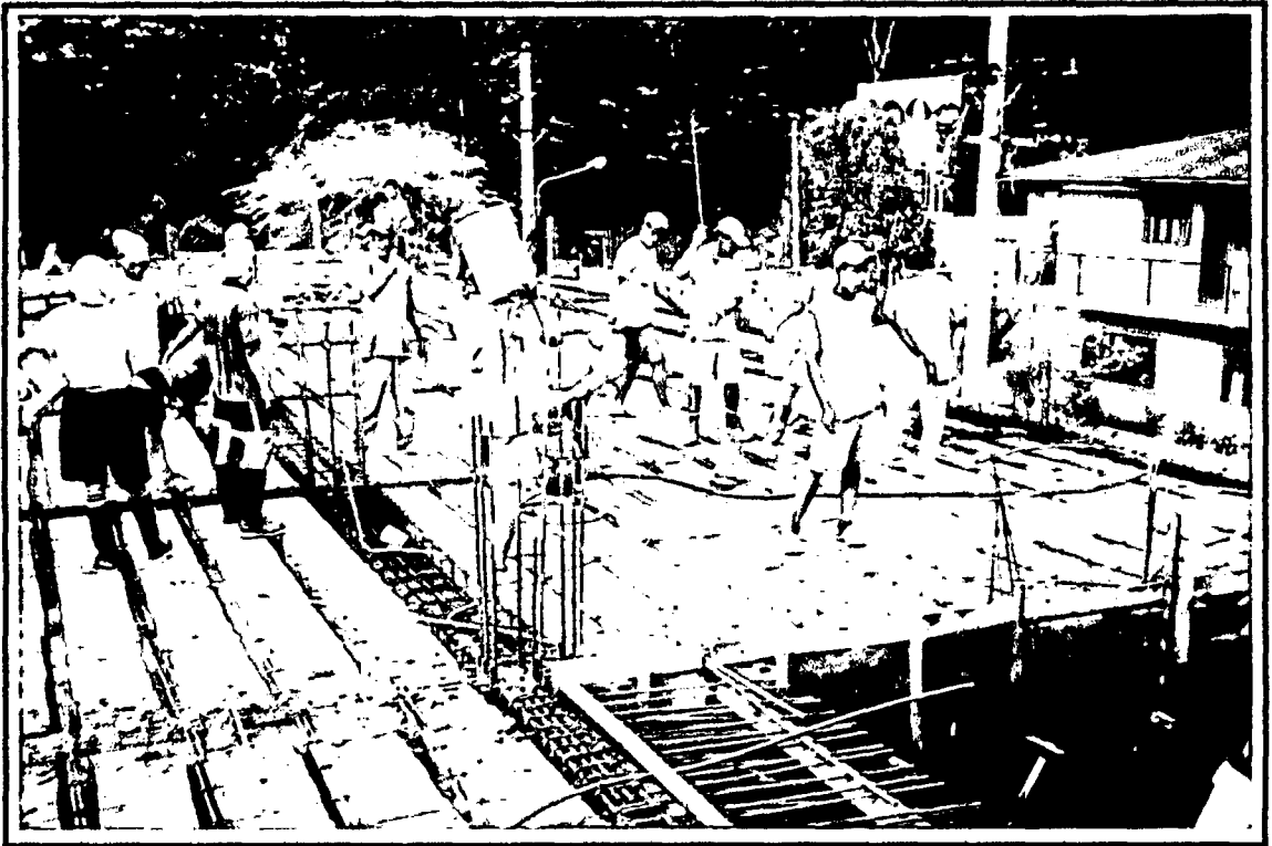
Anexo N° 8.7: Proceso de vaciado de losa aligerada segundo nivel
