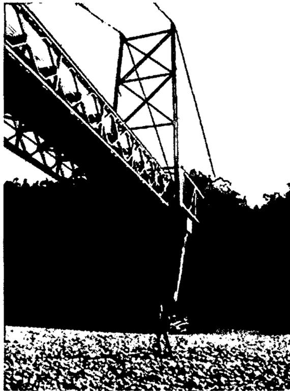
4: VISTA DE PARANTES DE TORRE, ARRIOSTRES LATERALES DEL PUENTE RETICULADO, PILAR EN EL LADO DERECHO DEL PUENTE.
