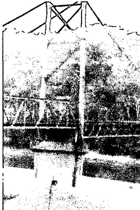
VISTA DE PARANTES DE TORRE, ARRIOSTRES LATERALES DEL PUENTE RETICULADO, COLGANTE Y PILAR EN EL LADO DERECHO DEL PUENTE ANTES.
