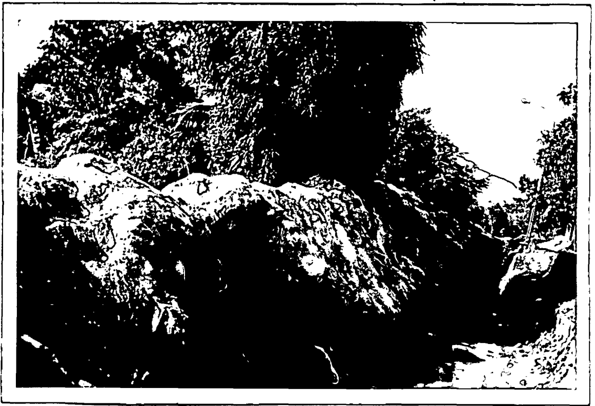
Zanja para desagüe en la zona 9. El desmante que se observa de la excavación, corresponde a un conglomerado de cantos rodados, con 40% de matriz areno arcillosa.
