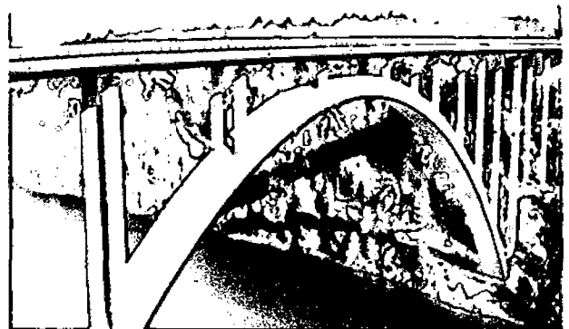
Figura 2.7: Puente Arco de Concreto
