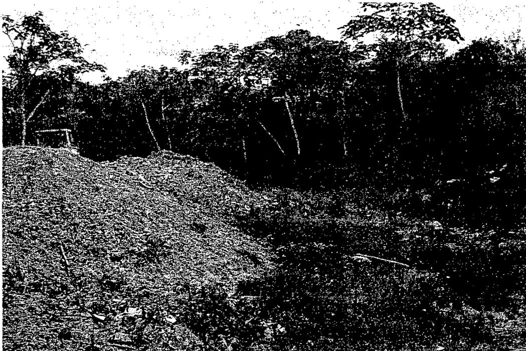
**FOTO N° 04:** Relleno con material de desmonte y escombros en la parte media del Barranco Tumino.
