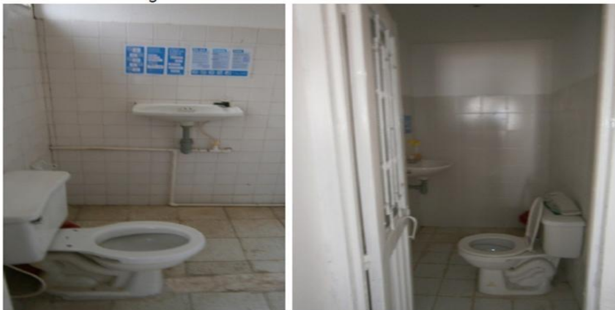
Figura 6. Baño para usuarios / baño funcionarios.
