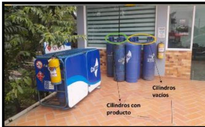
Los cilindros gas de 100 y 40 lb se encuentran en posición vertical, sin embargo, los de 100lb no están asegurados, ni separados los llenos de los vacíos, para evitar posibles accidentes o lesiones.
