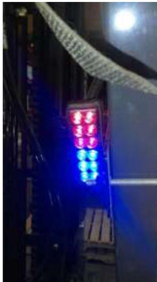
Ilustración 24. Luz indicadora de proximidad de montacargas.
